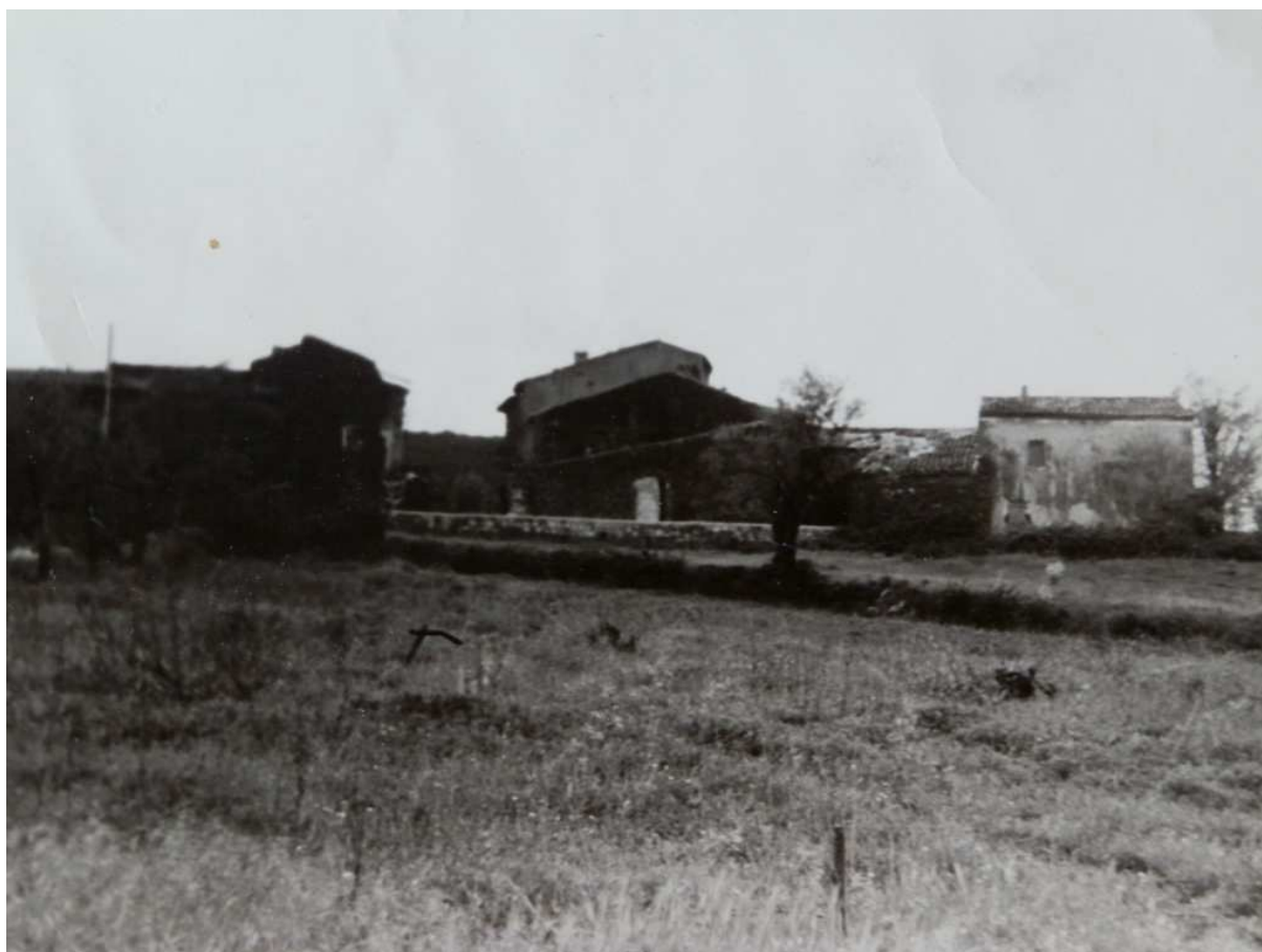
Ancien hameau de La Braunhe, détruit en 1970. (Justin Reveilhe, 1962)
