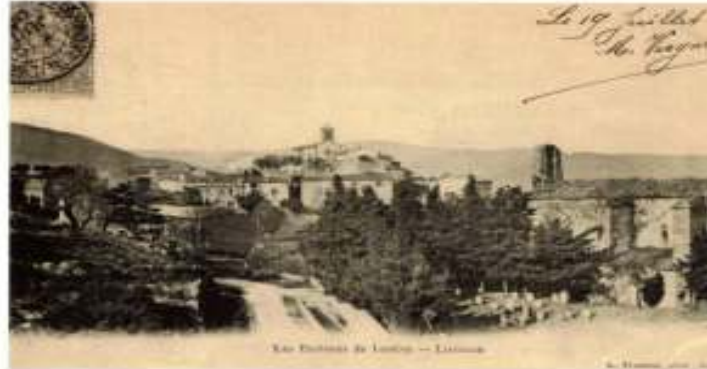
Photo où l'on voit une dernière fois cette église avant sa démolition avec la nouvelle.
